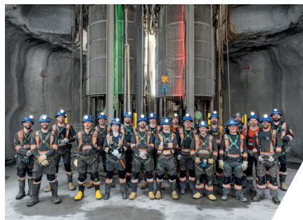
Une des équipes dédiées au fonçage du puits.
