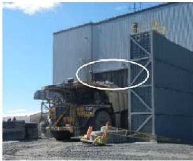
Installation de rideaux au concasseur
