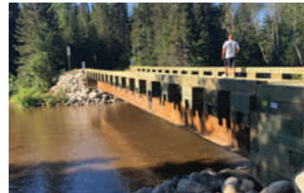
Club de motoneige de Malartic – Reconstruction du pont Goldfield : 25 000 $
